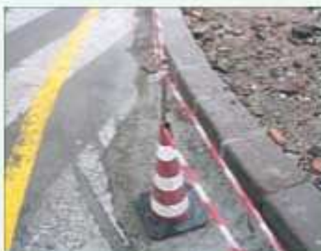
Situazione non regolare, il ferro sporgente dal cordolo non è protetto
