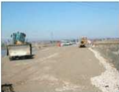
Esempio di mezzi d'opera semoventi in cantiere
