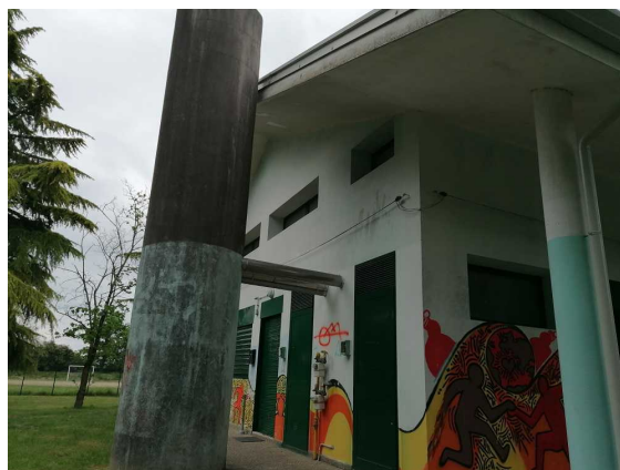
Foto palazzina servizi zona caldaia
